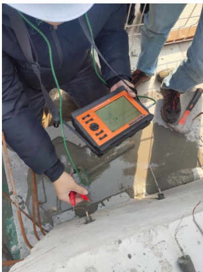
图4 灌浆饱满度检测
