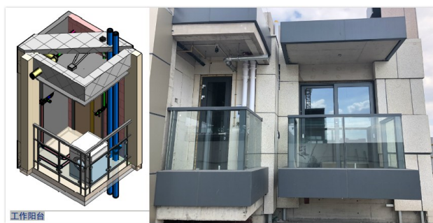
图2 工作阳台BIM模拟与样板建造
