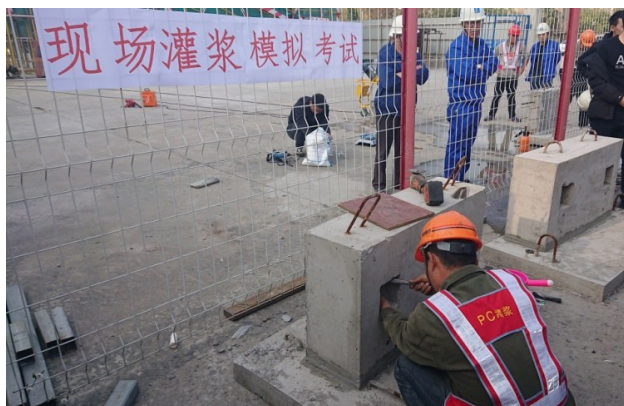
图3 套筒灌浆现场实操模拟
